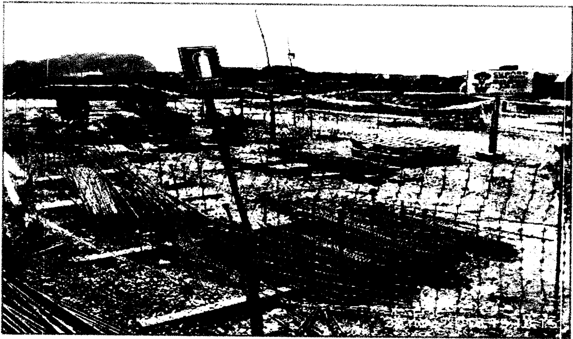
Imagen N° 14: A la vista de la imagen se aprecia señalizado con mallas de seguridad el área de acero.
